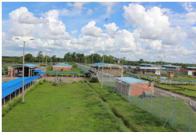
Figura 4. Establecimiento de Mediana Seguridad de Yopal Casanare
