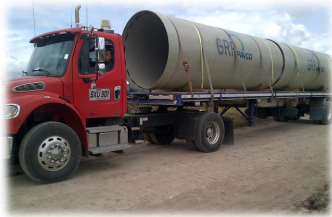
Ilustración 12 Transporte tubería espigo x espigo
