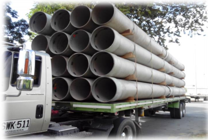
Ilustración 13 Transporte tubería diámetros pequeños campana vs espigo
