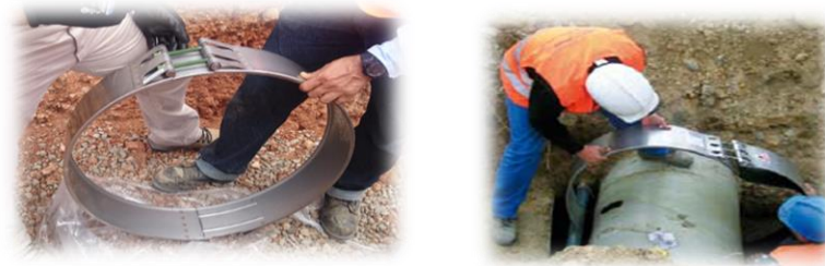
Ilustración 10 Uniones Flexibles con empaque
