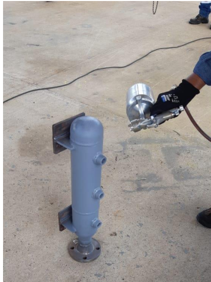
Figura 33. Construcción pulmón de aire, registro fotográfico tres. Fuente: El autor.
