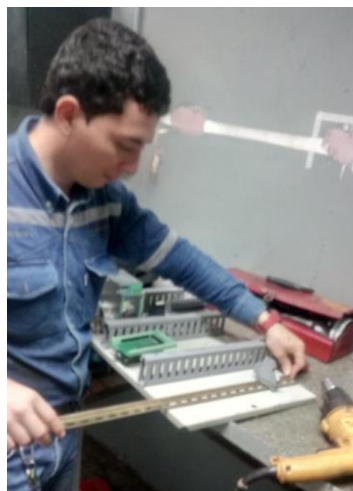
Figura 37. Construcción tablero eléctrico, registro fotográfico dos. Fuente: El autor.
