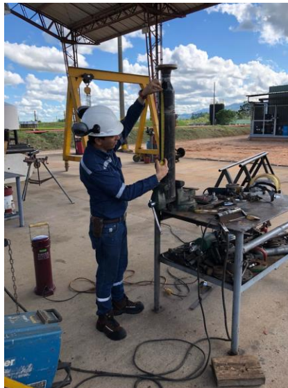
Figura 31. Construcción pulmón de aire, registro fotográfico uno. Fuente: El autor.
