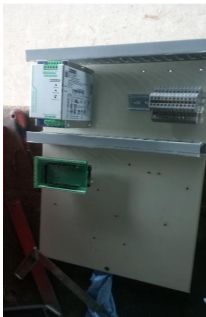
Figura 36. Construcción tablero eléctrico, registro fotográfico uno. Fuente: El autor.
