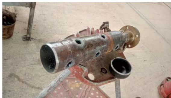
Figura 32. Construcción pulmón de aire, registro fotográfico dos. Fuente: El autor.
