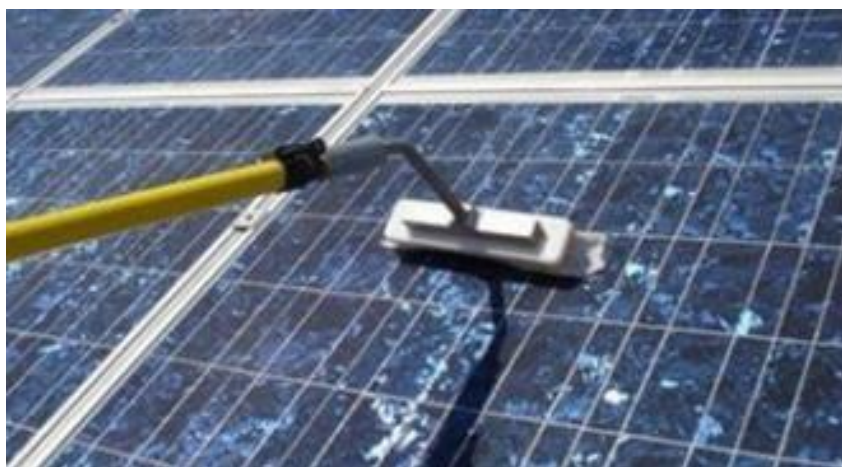
Ilustración 9. Limpieza de paneles
