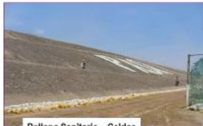
Relleno Sanitario - Celdas
