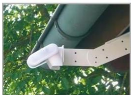
Fig. 7 Ejemplo de uso del brazo articulado: Mediante el brazo articulado, el sensor sobresale por debajo del alero. El sol puede actuar libremente sobre los sensores.
