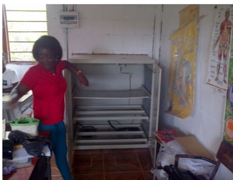
Figura 16 Banco de baterías
