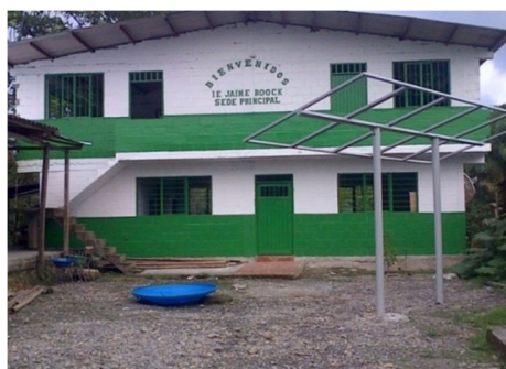
Figura 15 Infraestructura para los paneles solares
