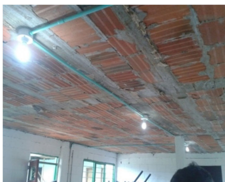
Figura 26 Sistema de energia funcionando
