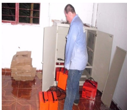
Figura 22 Montaje de Banco de baterías
