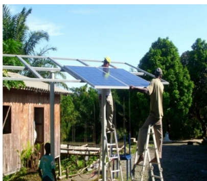
Figura 20 Montaje de paneles solares
