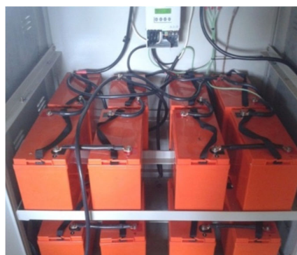
Figura 23 Banco de baterías instalado
