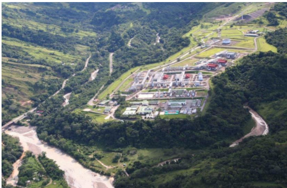
Figura 2. Vista aérea del CPF Cupiagua.
