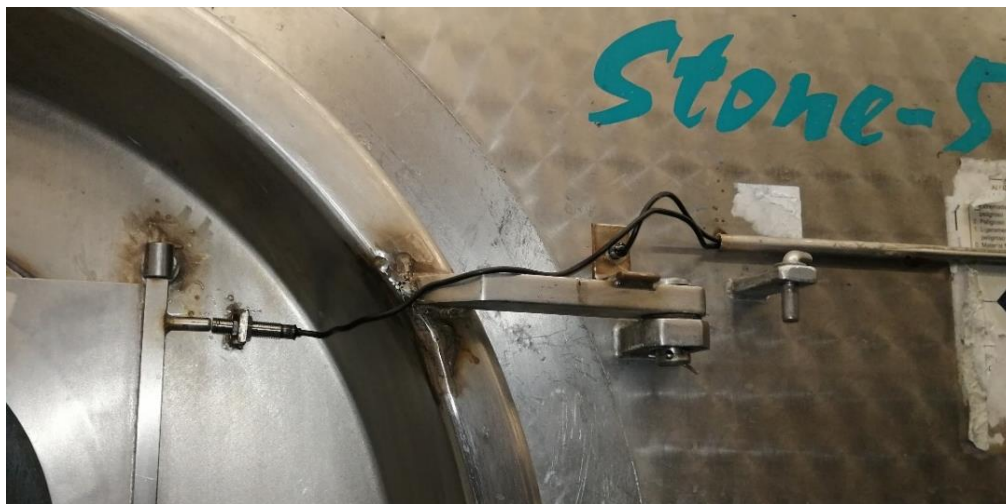
Imagen 22, Sensores instalados (Fuente: elaboración propia)
