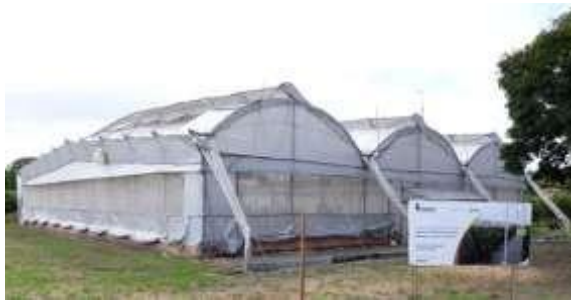
T3 Invernadero automatizado cerramiento perimetral en ladrillo a la vista modelo túnel ventilación cenital y extractores de aire.
