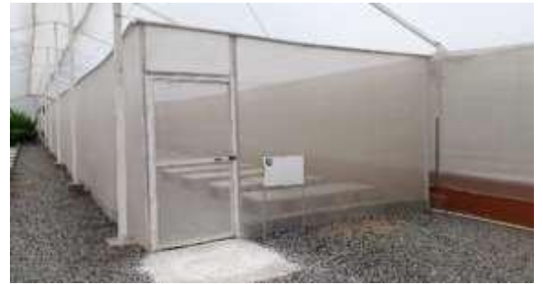
T4 Casa malla anti pulgón cuarentena modelo capilla con doble cubierta.
