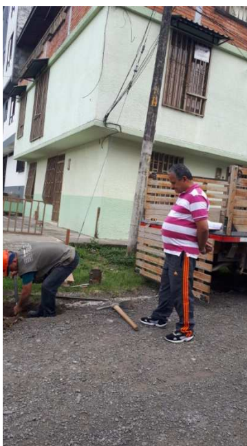
Fotografía 8 Vista general de uno de los apiques ubicado en vía del barrio Samaria II. Municipio de Pereira. (Punto 65).
