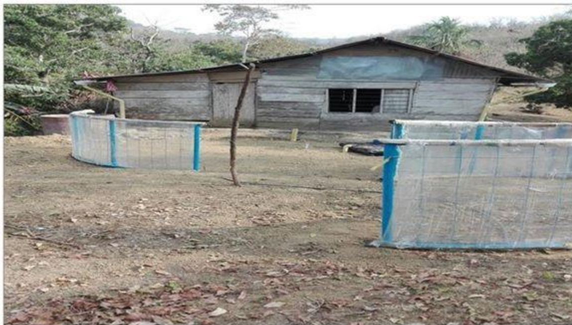
Ilustración 116. Preparación del terreno para tanque en geomembrana para piscicultura
