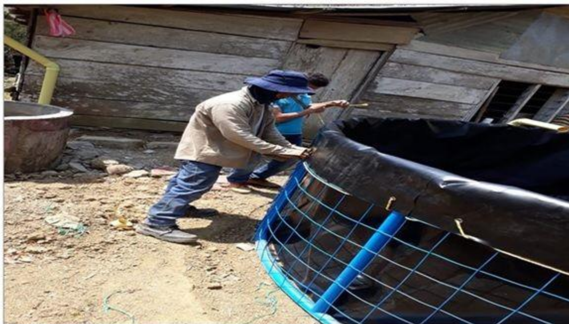
Ilustración 117. Personal de Alfa Co S.A.S., terminando con la instalación del tanque en geomembrana para piscicultura
