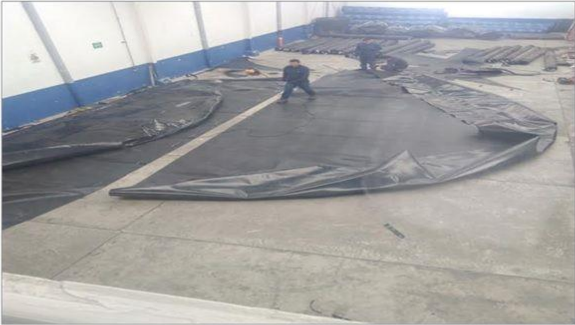
Ilustración 114. Personal de Alfa Co S.A.S., preparando la geomembrana
