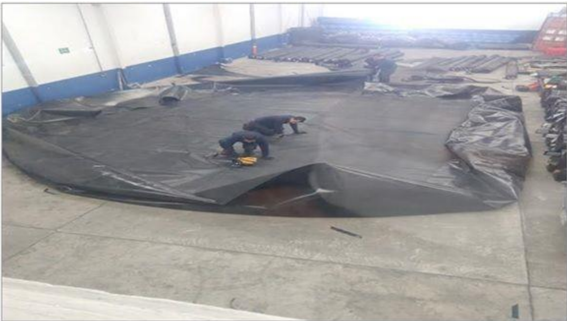
Ilustración 115. Personal realizando sellado de módulos
