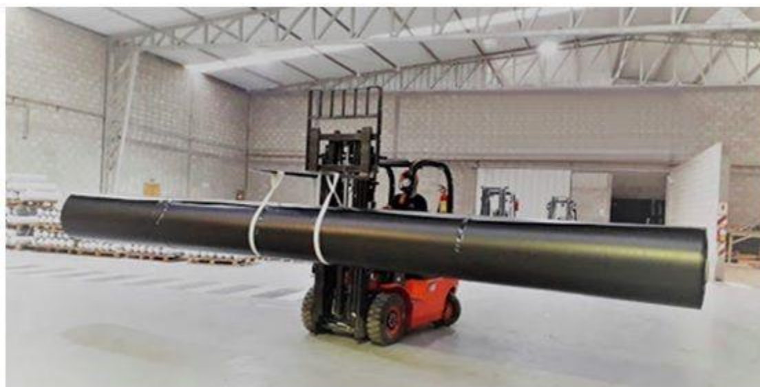
Ilustración 68. Transporte de geomembrana en montacargas
