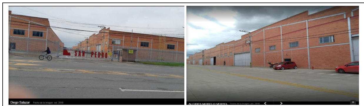
Ilustración 2. Fotografía Plano abierto frente y lateral del Centro de Distribución Permoda Ltda. en Funza. Fuente: Google Maps
