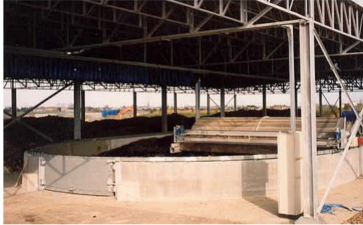
Figura 8. Volteador de túnel mediante palas (ANDALUCIA, 2018)
