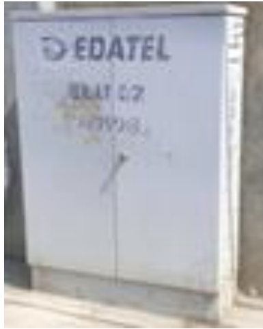
Figura 2. Armario 6, Montería, fuente: Elaboración propia
