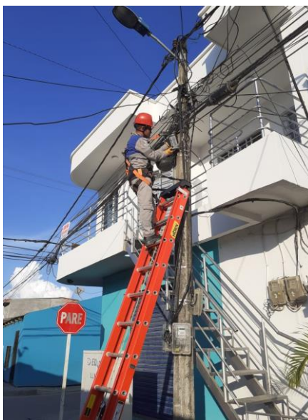
Figura 15. Marcación de caja de abonado, fuente: elaboración propia.
