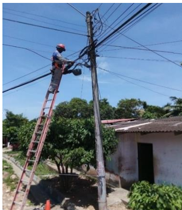
Figura 3. Trabajos en red de planta externa. Fuente: elaboración propia.
