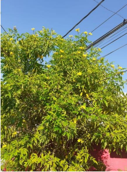
Figura 12. Cable en riesgo por poda, fuente: Elaboración propia.
