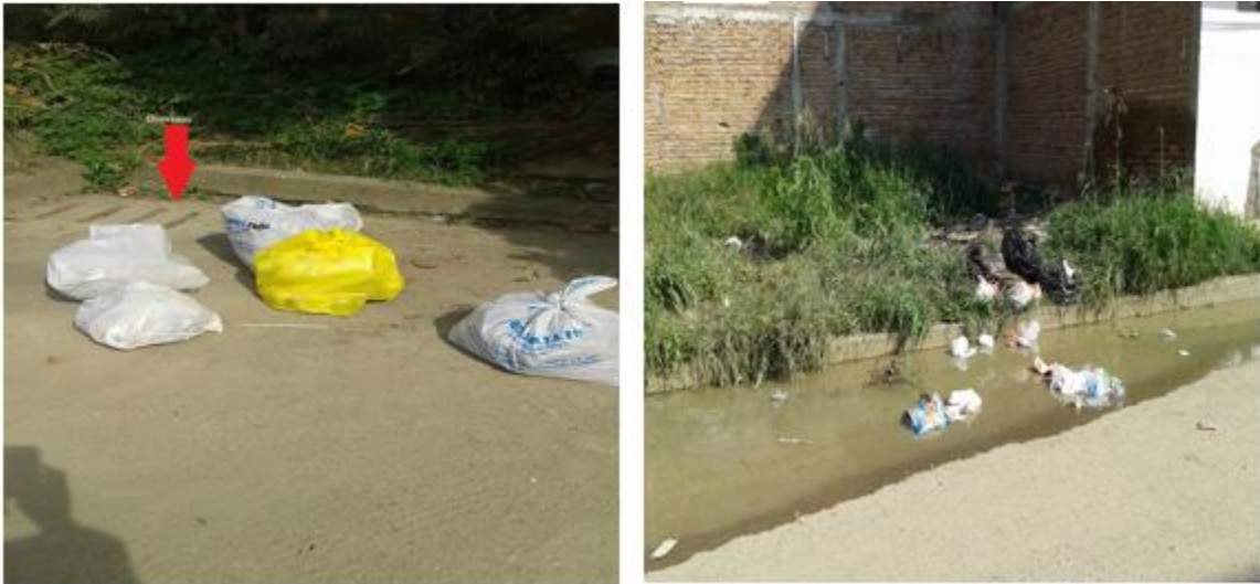
Figura 6. a). Residuos Sólidos cerca de los drenajes de aguas lluvias b). Taponamiento del drenaje por residuos sólidos
