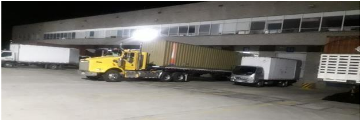
Ilustración 30 muelle de carga y descarga Nota: Tomada de Belcorp.
