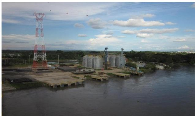
***Ilustración 40. Sociedad Portuaria de Barrancabermeja, Terminal Fluvial de Galán (Vista 1), Sistema de 6 silos de 980 Ton c/u (5.880 Ton) con 2 silos de despacho (4.200 Ton/día).***
