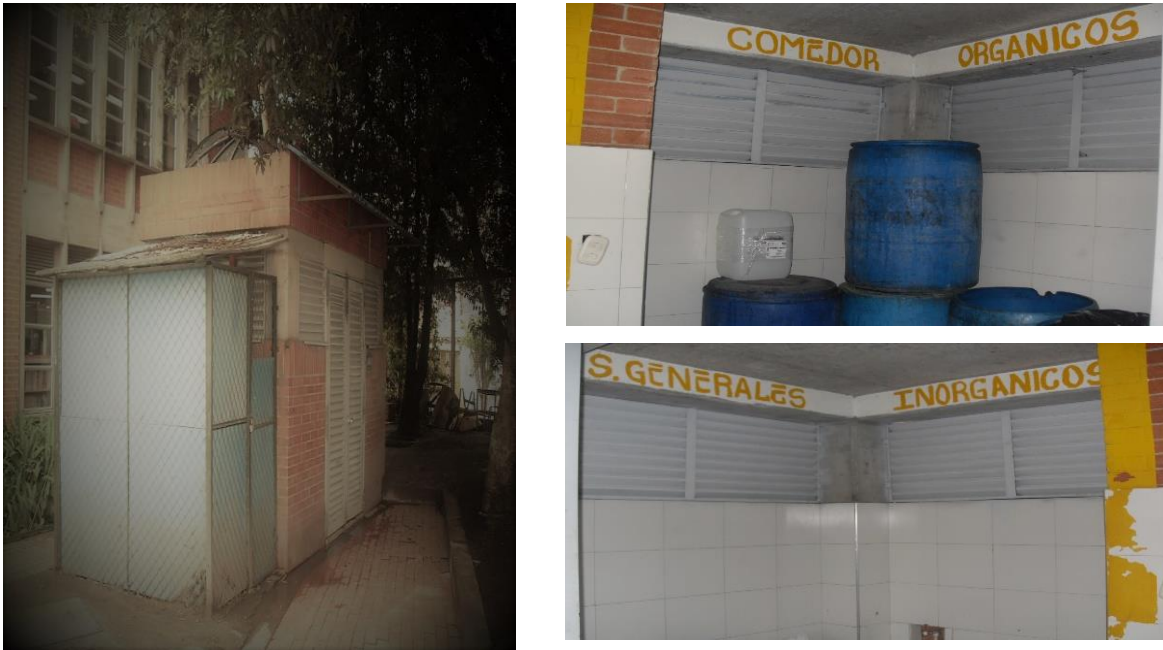
Figura 10. Cuarto de almacenamiento de residuos – Condición actual
