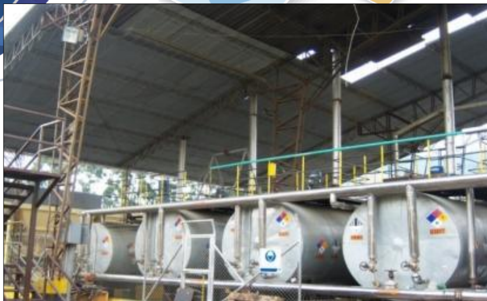
Ilustración 27. Método de almacenamiento de materiales especiales. Fuente: Elaboración Propia.
