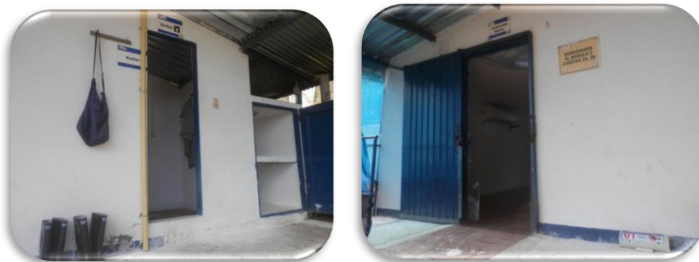
Figura 34 Zona de cuarto y baños módulo 2 AVICOL. Fuente: El autor
