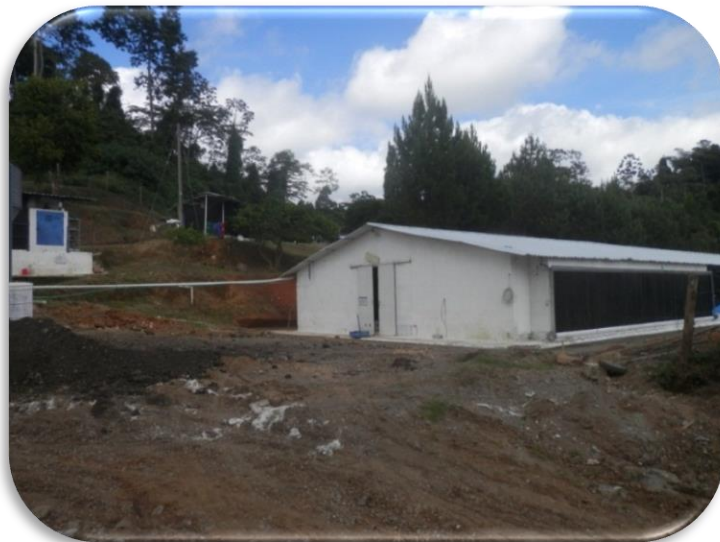
Figura 6 Techos de los galpones AVICOL. Fuente: El autor
