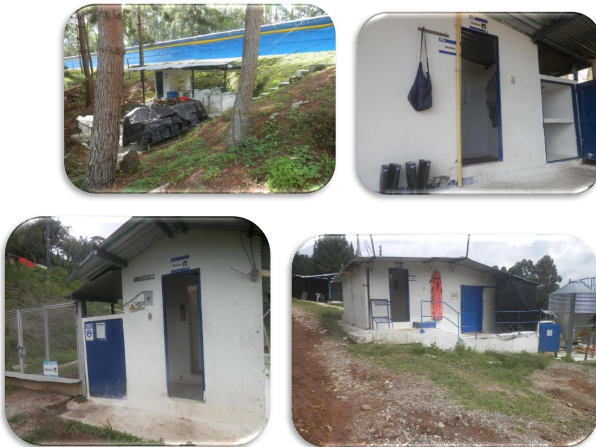
Figura 12 Zona de duchas AVICOL. Fuente: El autor
