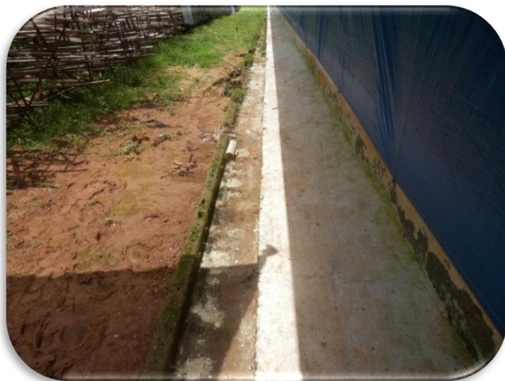
Figura 5 pisos próximos hacer reformados. AVICOL. Fuente: El autor
