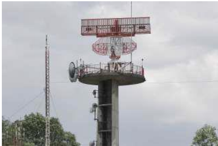
Figura 6. Torre de comunicación aeroportuaria
