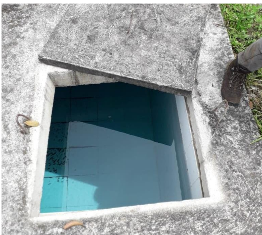
Figura 12. Interior tanque de almacenamiento Figura 13. Tanque de almacenamiento Fuente: Elaboración propia, 2021
