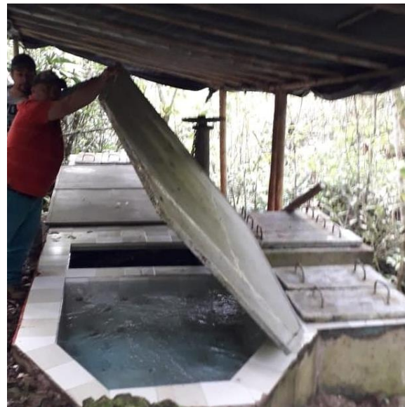
Figura 29. Desarenador
