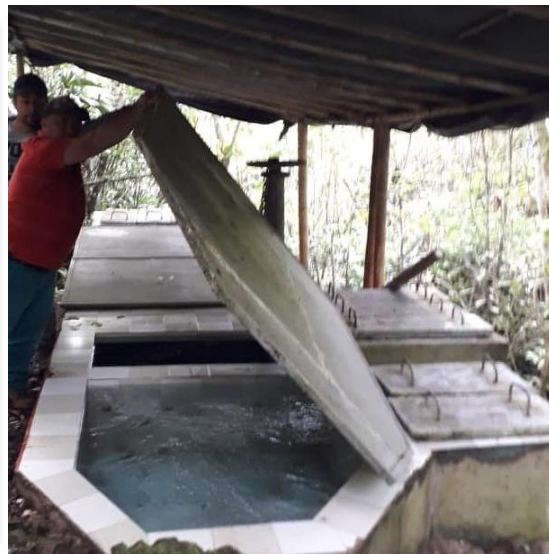
Figura 10. Desarenador
