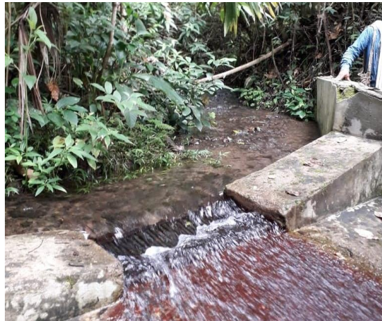
Figura 27. Bocatoma
