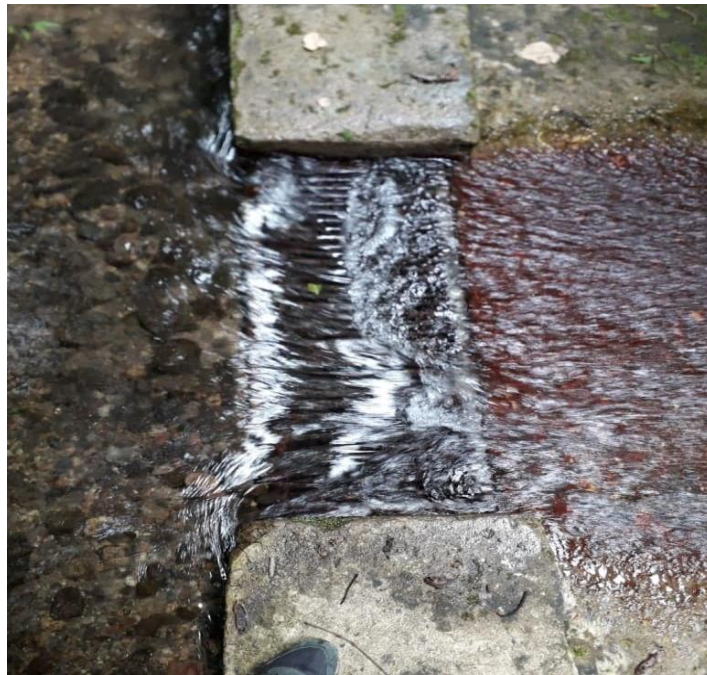
Figura 18. Rejilla bocatoma
