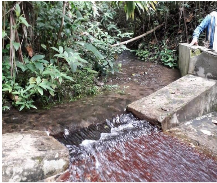
Figura 8. Bocatoma Fuente: Elaboración propia, 2021
