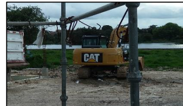
Figura 44. Obras de construcción en el tercio alto del Humedal Juan Amarillo. Ver Anexo 1
