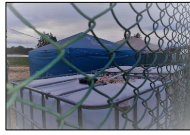
Figura 47. equipos y materiales instalados para la obra que se adelanta en el tercio alto del humedal Juan Amarillo
