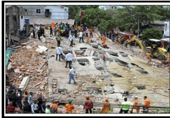
Figura 15. Desastre en edificación.
