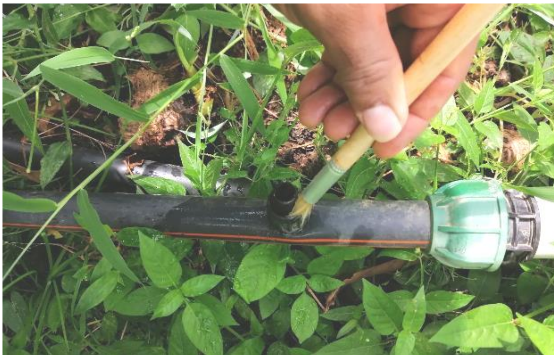
Ilustración 22: Limpieza de conectores
