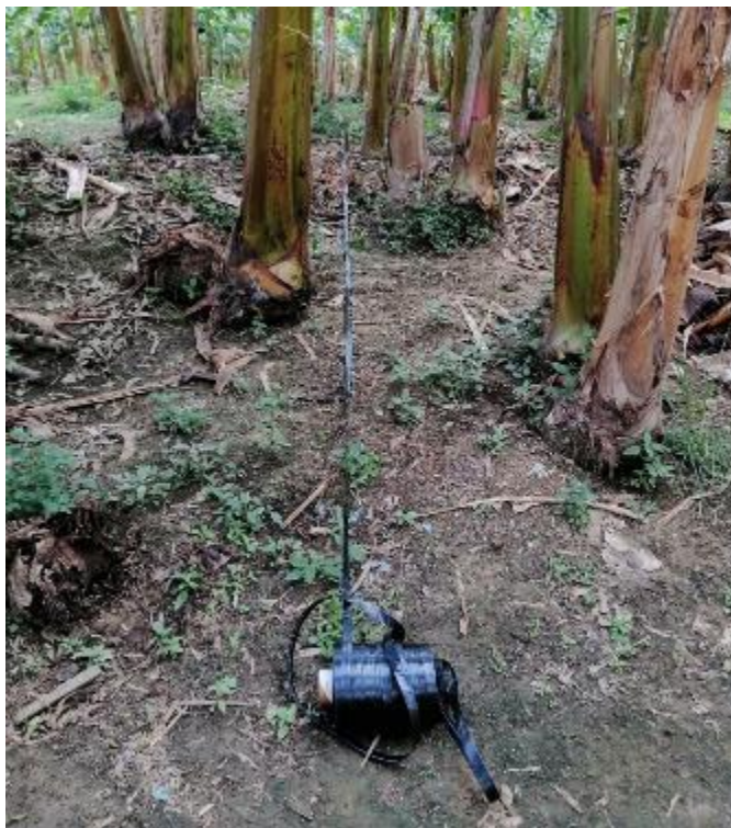
Ilustración 24: Instalando tubería nueva
