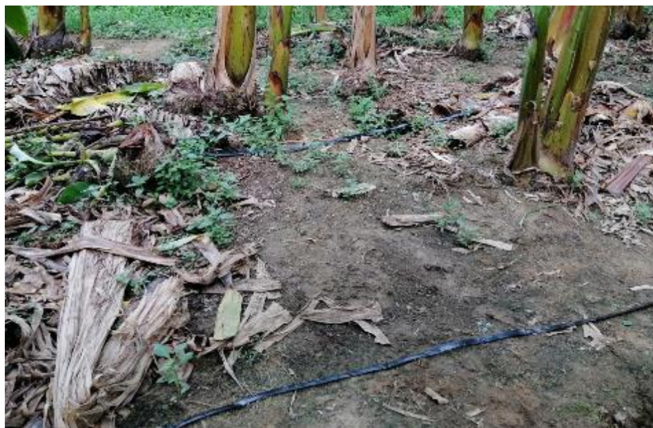
Ilustración 25: Tubería nueva instalada
