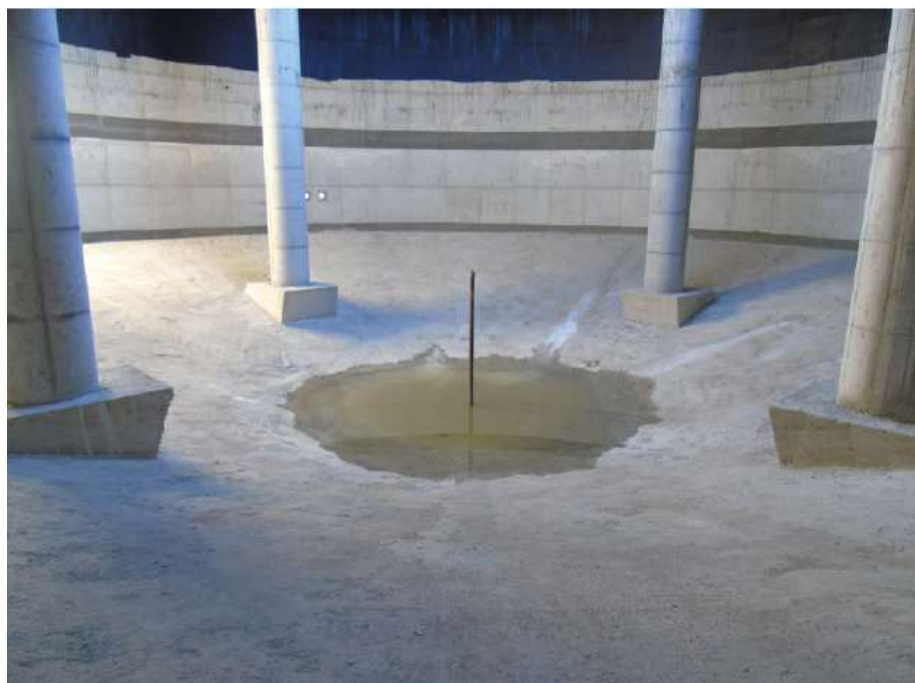
Figura 14 Interior de un digestor de hormigón con protección epoxi en la parte superior
