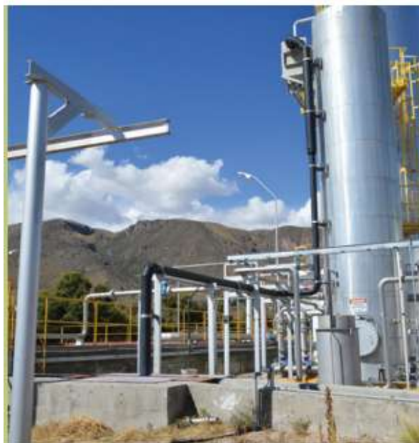
Figura 12 Biodigestores semicontínuos o continuos húmedos en dos etapas
