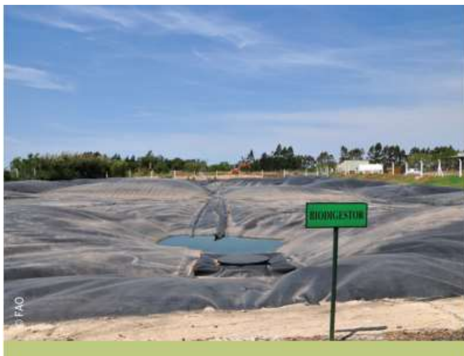
Figura 10 Biodigestores de laguna cubierta de media-baja tecnología
