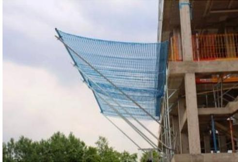
*La figura muestra una red de seguridad del sistema T instalada en estructura de hormigón de obra de edificación. Tomado de Sistemas de redes de Seguridad de Protecciones Colectivas (ProteccionesColectivas, s.f.).*
