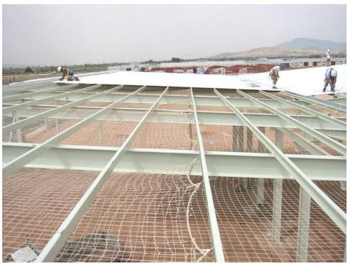
*Nota. La figura muestra una red de seguridad sistema S, instalada bajo una estructura metálica. Tomado de Sistemas de redes de Seguridad de Protecciones Colectivas (ProteccionesColectivas, s.f.).*
