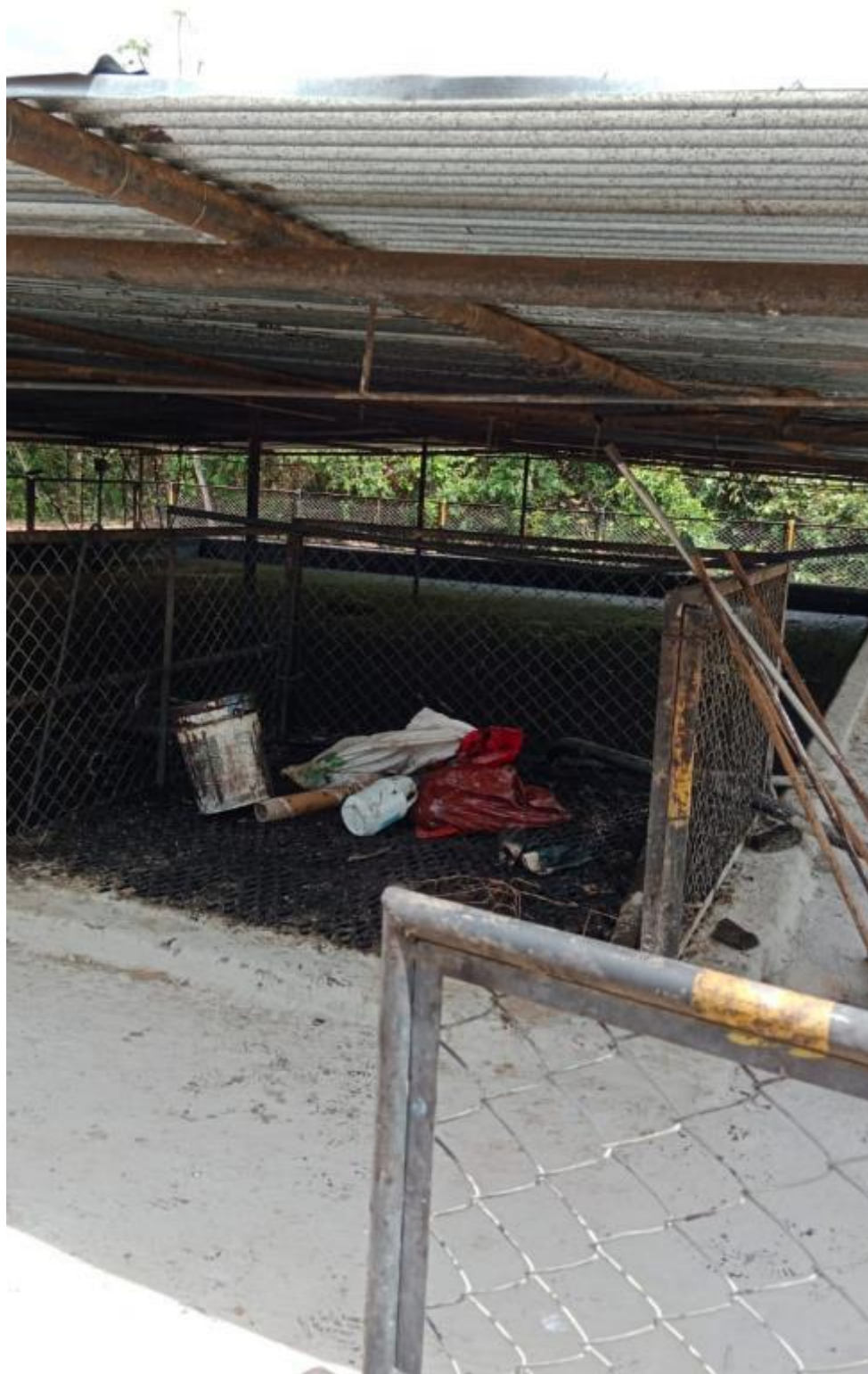
Fotos 14. Almacenamiento de residuos peligrosos en área de piscina de borras.
