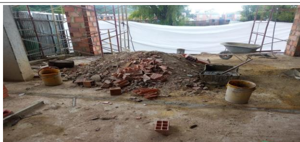
Imagen 19. RCD Obra de construcción del Sr Gerardo Pascagaza. Fuente J Daniel Yepes Gómez (2021)
