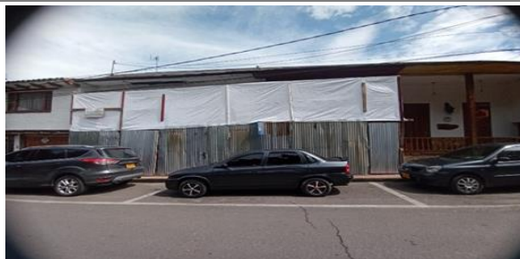
Imagen 10. Obra de Construcción Sr Daniel González ubicada en Sopo Centro. Fuente J Daniel Yepes Gómez (2021)
