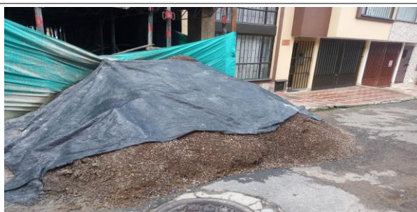
Imagen 21. Material de Construcción de la Obra perteneciente al Sr Joaquín Emilio Aguirre Pulido ubicada en el centro. poblado de Sopó. Fuente J Daniel Yepes Gómez (2021)
