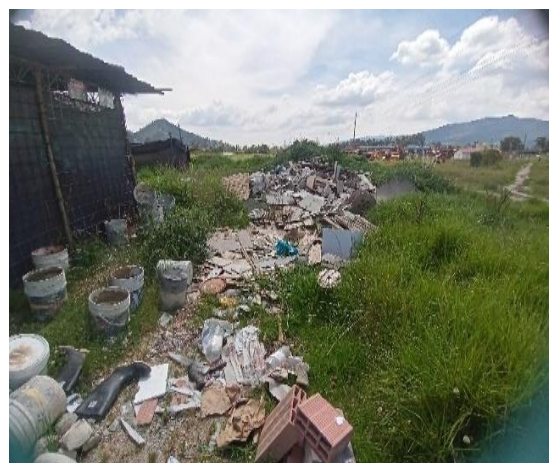
Imagen 46 RCD en el área del proyecto en un estado Sin Manejo, Fuente J Daniel Yepes Gómez (2021)
