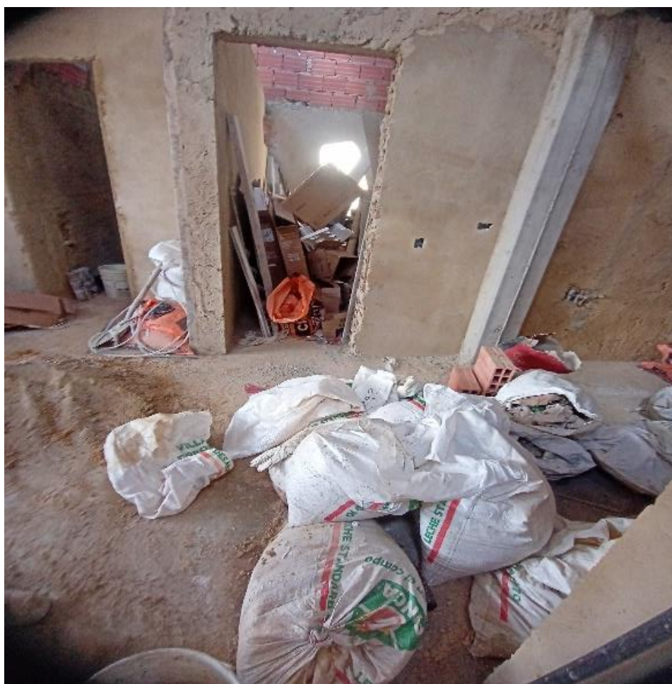
Imagen 22. Obra de Construcción calle 4 # 3-98 Fuente J Daniel Yepes Gómez (2021)
