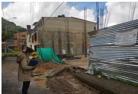
Imagen 23. Obra de Construcción carrera 1a Este. Fuente J Daniel Yepes Gómez (2021).
