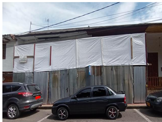
Imagen 36 Obra de Construcción ubicada en la Calle 3 N° 2-40. Fuente J Daniel Yepes Gómez (2021)
