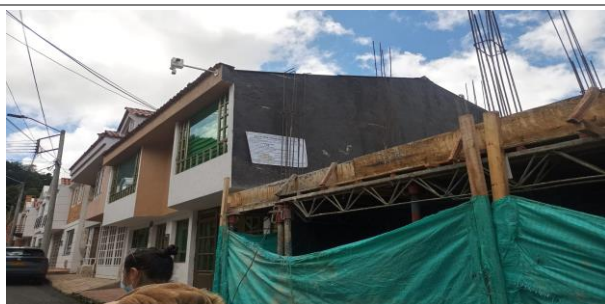
Imagen 20. Obra de Construcción Sr Joaquín Emilio Aguirre Pulido centro poblado Sopó. Fuente J Daniel Yepes Gómez (2021)
