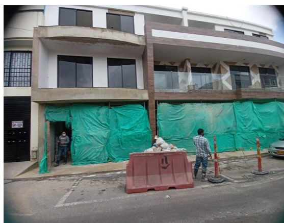
Imagen 33. Obra de Construcción ubicada en las coordenadas geográficas 4° 54'27.28" N, 73° 56'28,67" O. Fuente: J Daniel Yepes Gómez (2021)
