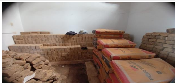
Imagen 13. Obra de Construcción Sr Daniel González ubicada en Sopo Centro Área de almacenamiento. Fuente J Daniel Yepes Gómez (2021)
