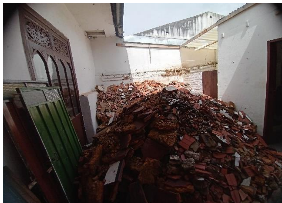
Imagen 35 RCD de materiales de Construcciones ubicados en la obra calle 3 N° 2-40. Fuente J Daniel Yepes Gómez (2021).
