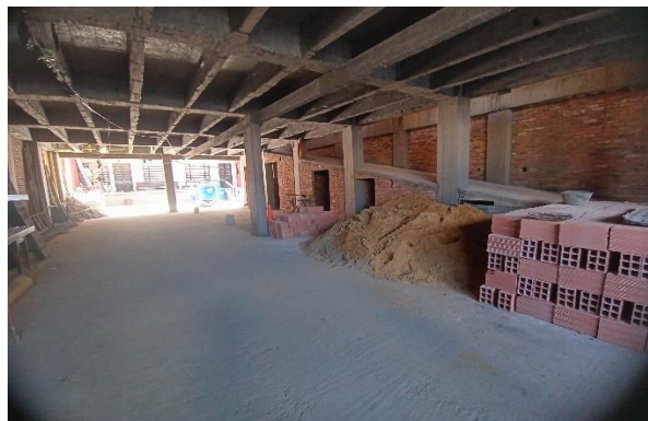
Imagen 39 construcción nueva de la Carrera 4 N° 1-64 Fuente: J Daniel Yepes Gómez (2021)
