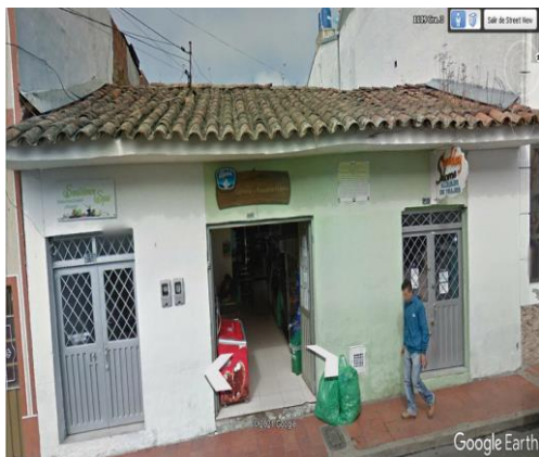
Imagen 37 Construcción para demolición en la carrera 3 N° 1-50 Fuente Google Earth.(2021)
