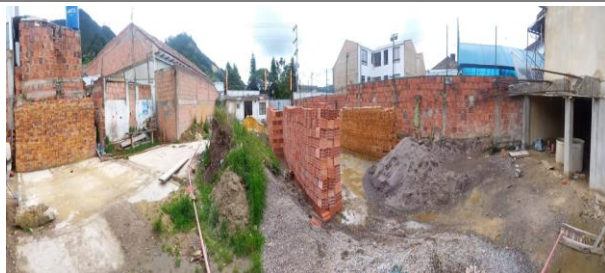
Imagen 16. Área construida por el Sr Carlos Salinas en el centro poblado de Sopó. Fuente J Daniel Yepes Gómez (2021)
