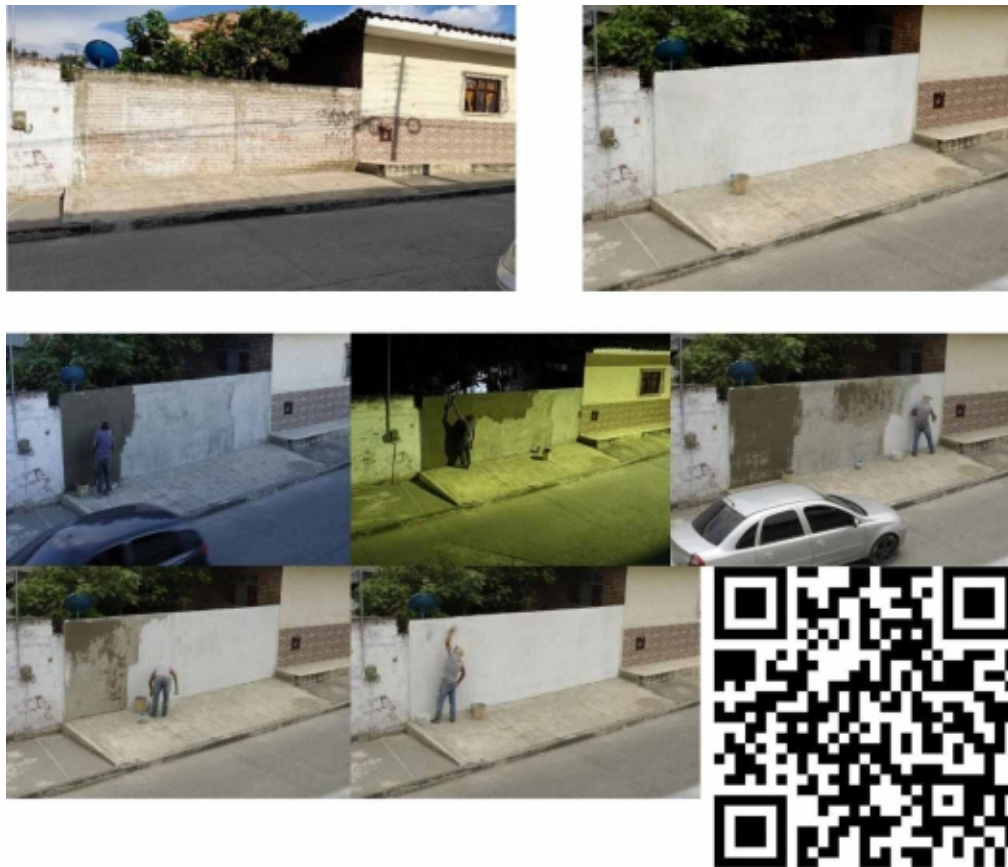
Time - Lapse. Preparación de la pared
