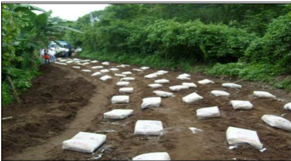
Distribución de Cal Manual Vía Seca
