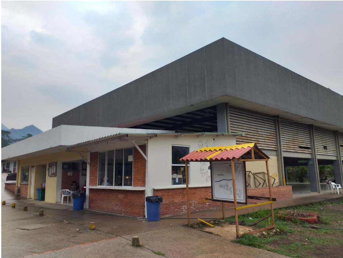
Fachada de la infraestructura de la IEC
