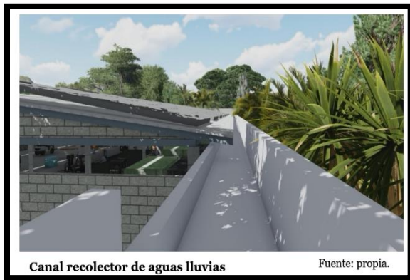
Figura 24: Sistema de Recogimiento de Agua
