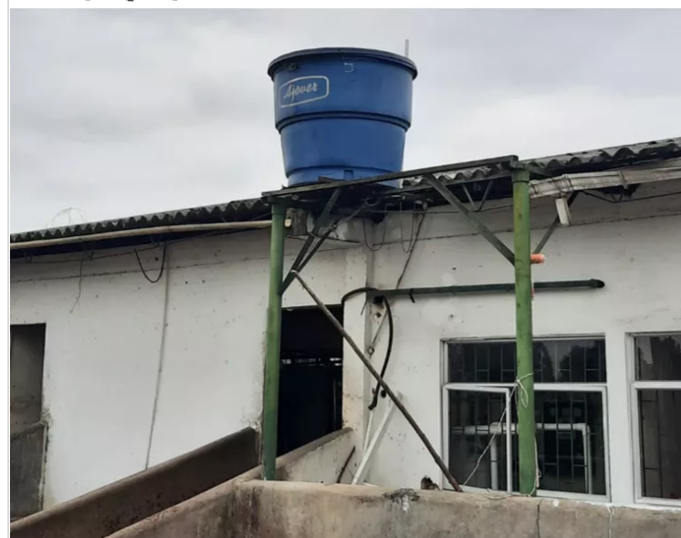
Figura 11: Beltrán, F. (2022). Sistema de almacenamiento de agua en el área de bovinos, [Fotografía].
