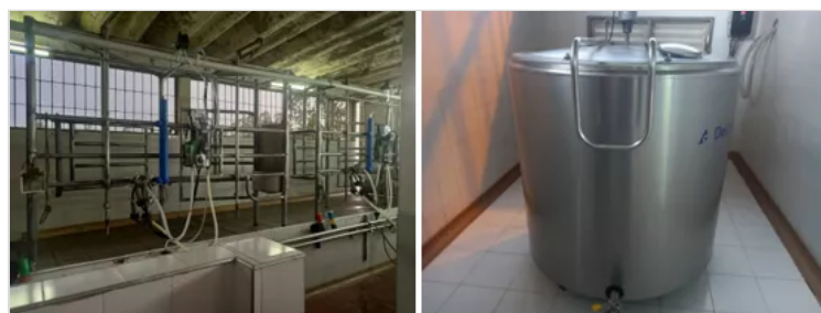
Figura 6: Silva, E. (2022). Instalaciones Finca La Esperanza. [Fotografía].
