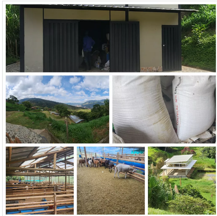
Figura 4. Instalaciones, oficina, bodega.
