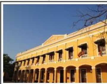
Antiguo Edificio de la Administración de la Aduana, Vía 40 No. 36 - 135.
