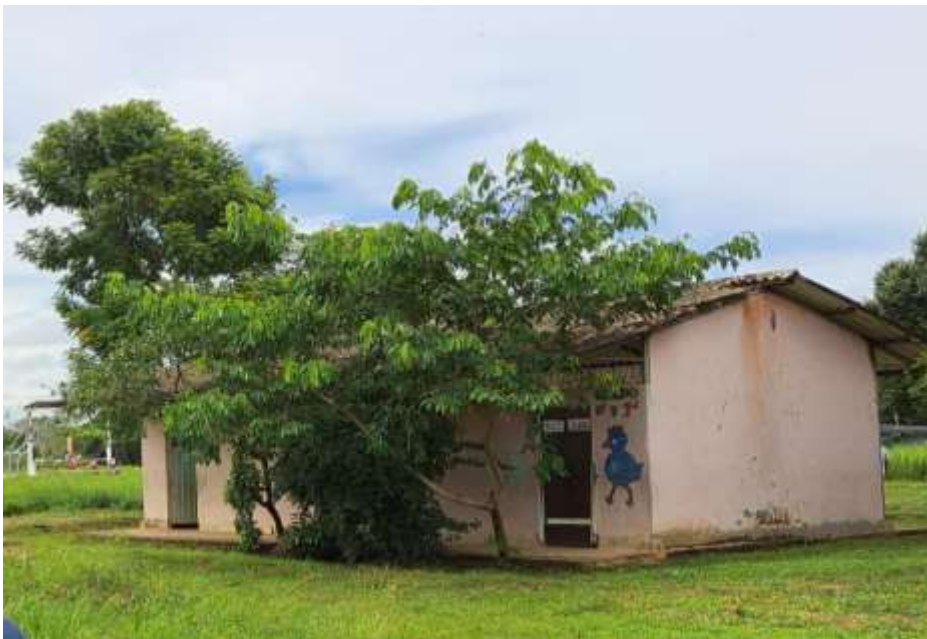
Figura 10. Escuela primaria sabanas de la fuga.
