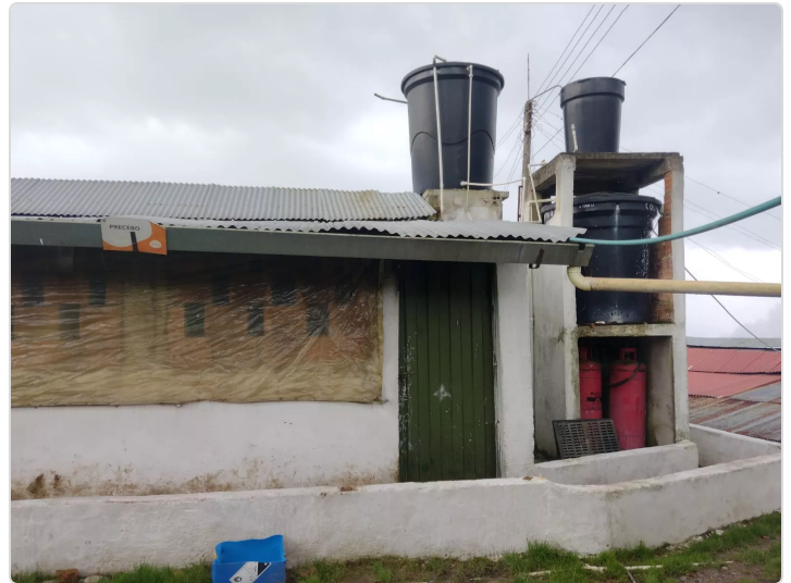
Figura 3. Instalaciones finca el refugio
