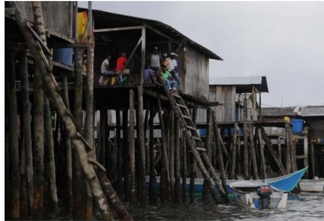
Figura 2. Construcción de viviendas sobre zona de manglar
