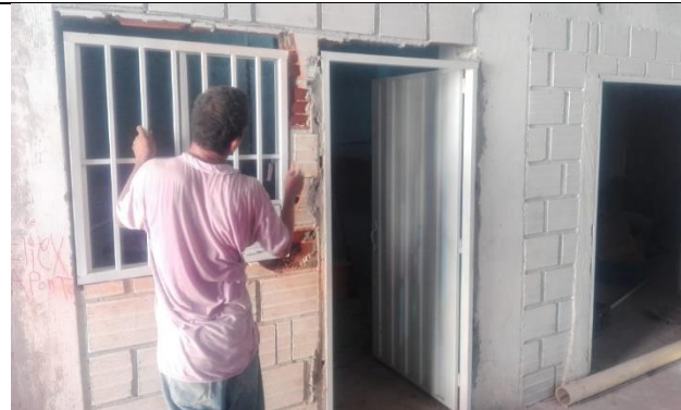
Levantamiento puerta de laboratorio
