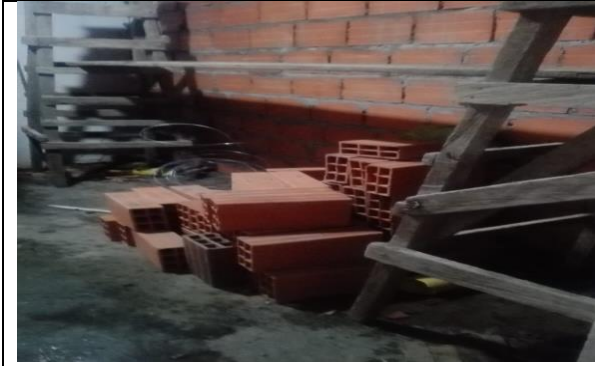
Levantamiento de muro de separación
