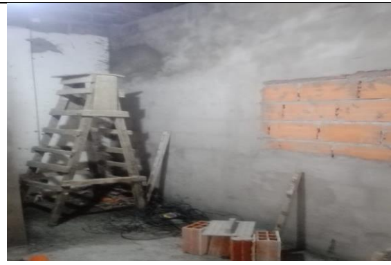
Levantamiento de muro de separación
