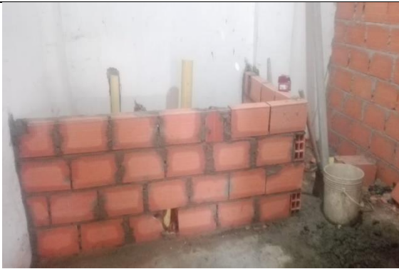
Construcción del baño
