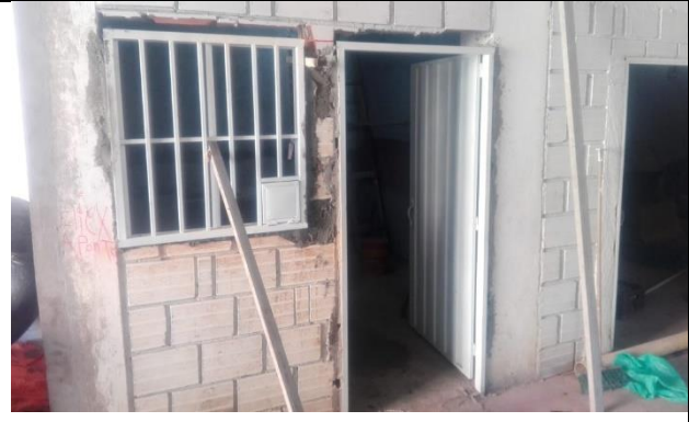
Levantamiento puerta de laboratorio
