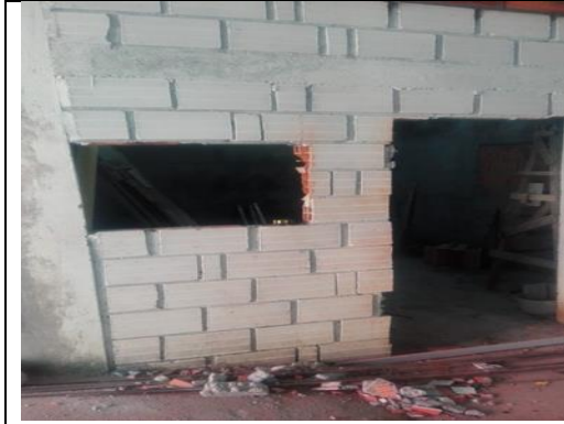
Levantamiento puerta de laboratorio
