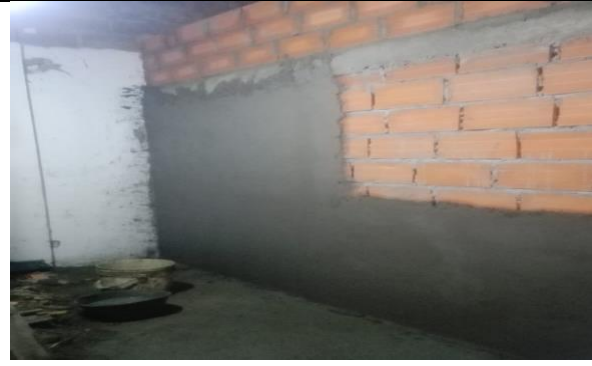
Levantamiento de muro de separación
