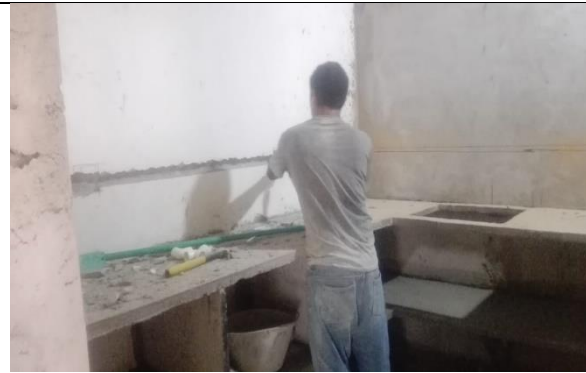
Fabricación mesón y conexiones de lab.
