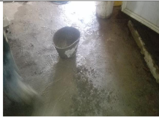
Materiales - Construcción Laboratorio
