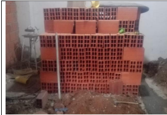
Materiales - Construcción Laboratorio
