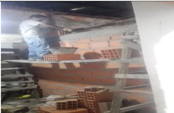
Levantamiento de muro de separación
