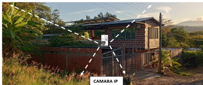
Imagen Lugar de Instalación Cámara IP
