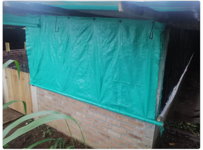
Figura 10. Sistemas de ventilación (Tipo cortinas)
