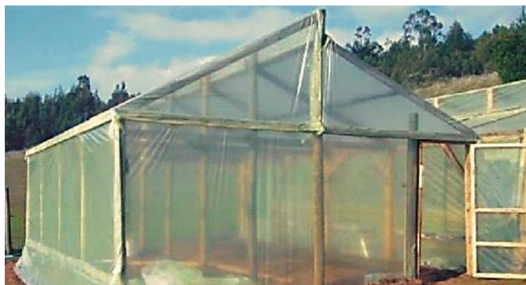
Estructura de invernadero tipo capilla en guadua
