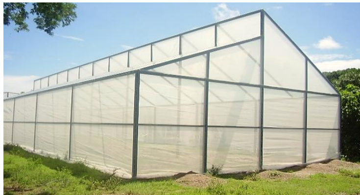
Estructura de invernadero tipo capilla en hierro galvanizado
