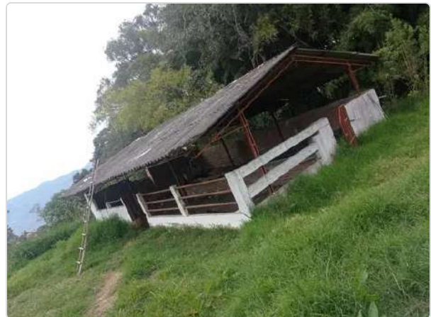
Figura 7 Establo de aislamiento para tratamiento de animales enfermos o cuarentena
