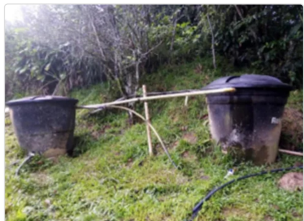
Figura 7. Tanques de depósito de agua para recambios.
