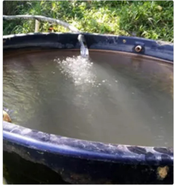
Figura 8. Tanque desarenador.
