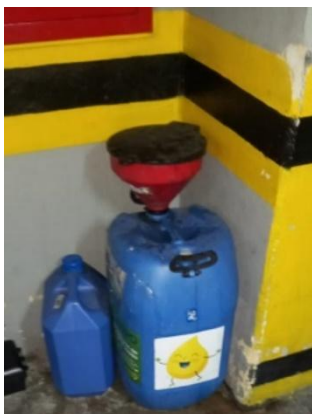
Figura 9 Contenedor de aceite
