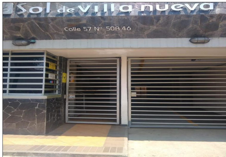
Figura 8 Fachada De la Empresa
