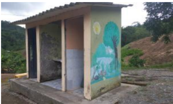
Baterías sanitarias del CE Pesquería Bajo
